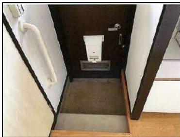
玄関部手すり・ステップ設置
