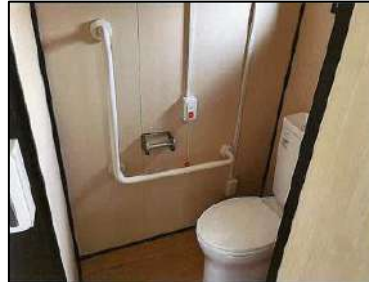
洋式トイレと手すり設置
