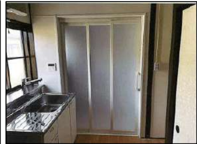
台所流し設置 ユニットバス設置(段差無)
