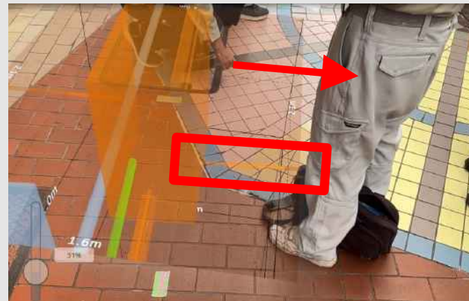
【埋設管位置マーキング】
