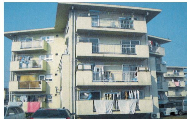
学生が入居予定の市営住宅の外観
