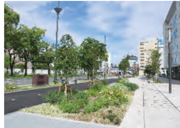
中央通りに整備したグリーンインフラ（レインガーデン）
