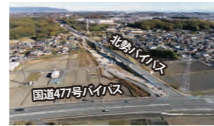
【整備が進む広域幹線道路】
