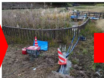
排水経路の確認
