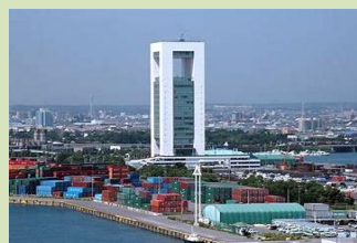
四日市港ポートビル (出典:クルーズ四日市HP)
