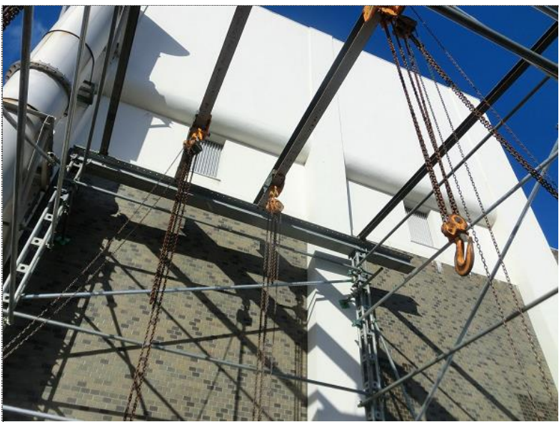
仮設の揚重設備 10tチェーンブロック4台
