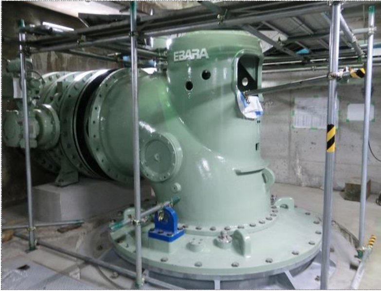
No. 6雨水ポンプ据付状況
