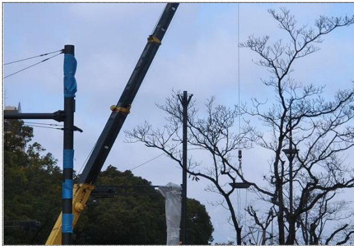
照明灯設置工事
