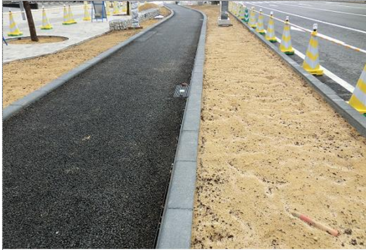
自転車道・透水性舗装 (中)スリット側溝流入孔
