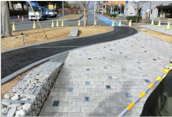
(右)インターロッキング舗装A (左)ポーラスアスファルト舗装 自転車道 (下左)蛇籠ベンチ
