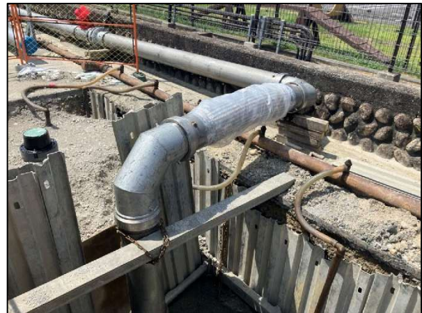
富士町仮設状況
