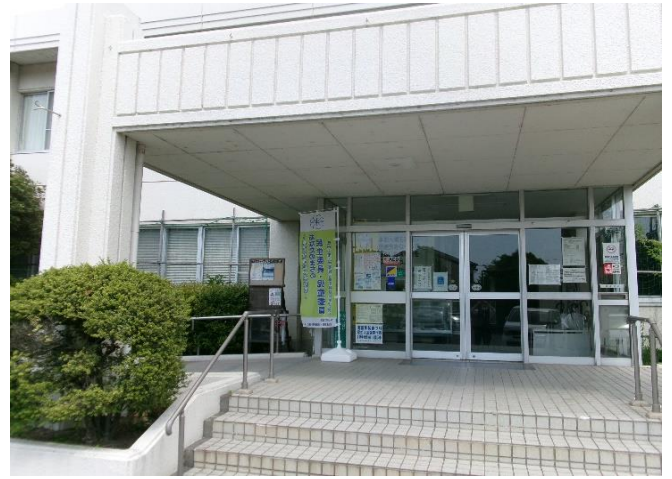
海蔵地区市民センター
