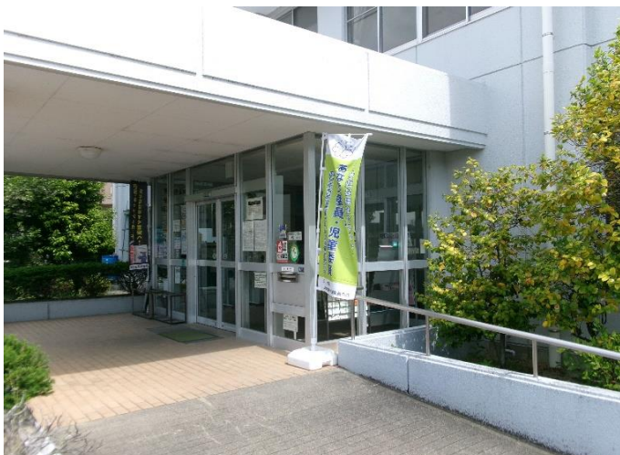
常磐地区市民センター
