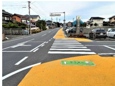
図 カラー舗装（日永東日野線）
