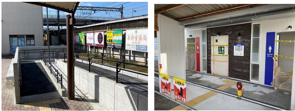
図 バリアフリー化整備を行った三岐鉄道暁学園前駅
