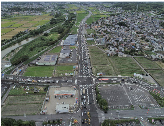
図 整備が行われた国道477号
