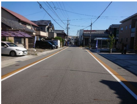
図 カラー舗装（中浜田南浜田線）
