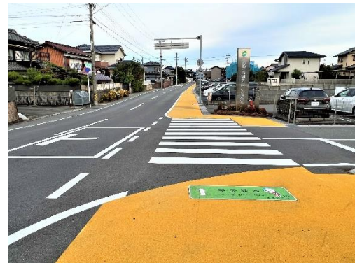
図 カラー舗装（日永東日野線）
