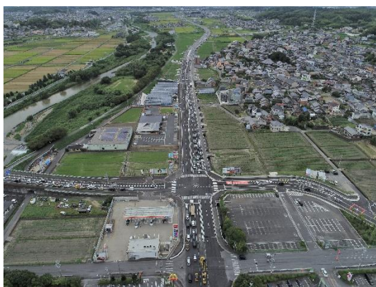
図 整備が行われた国道 477 号
