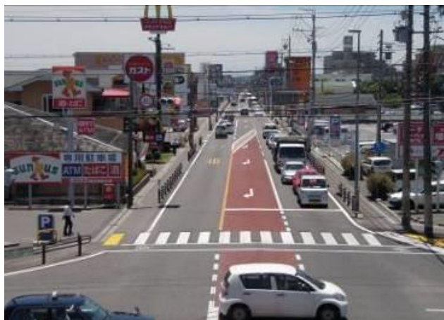
図 右折レーンのカラー舗装化（日永3丁目交差点）
