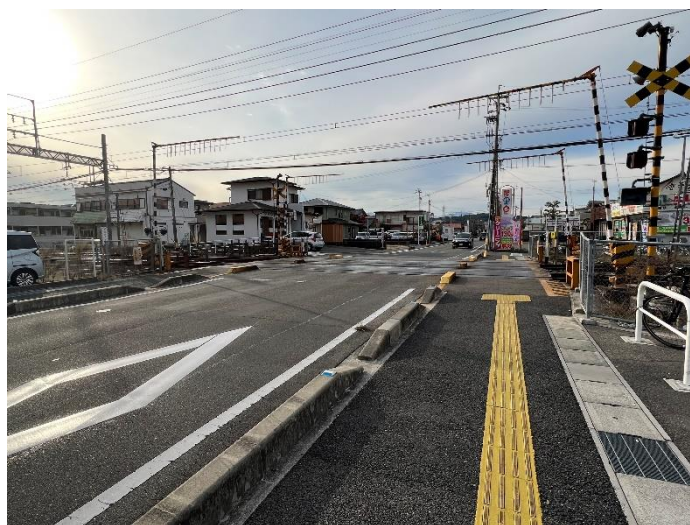
図 拡幅された踏切（市道霞ヶ浦垂坂線）
