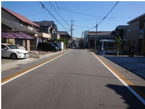
図 カラー舗装（中浜田南浜田線）
