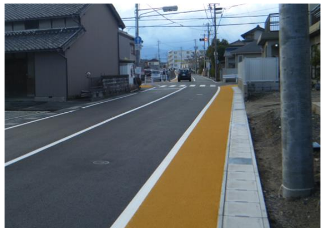
図 カラー舗装（日永東日野線）
