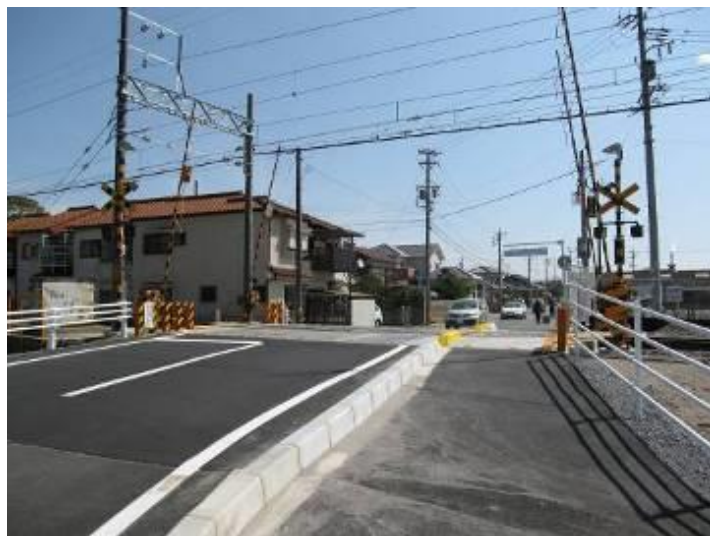
図 拡幅された踏切（市道日永東日野線）
