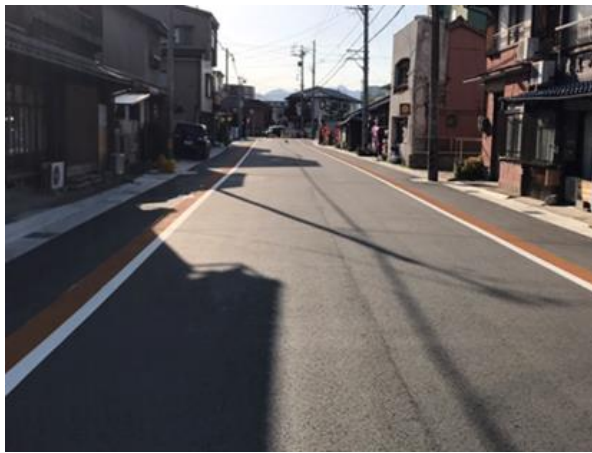
図 カラー舗装（中浜田南浜田線）
