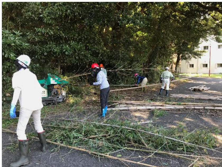
作業開始 竹の伐採とチップ化作業
