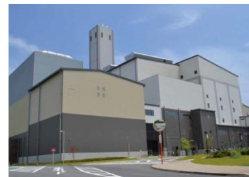
■ 四日市市クリーンセンター
