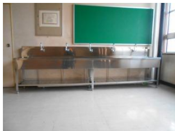
【東校舎手2階洗い場】
