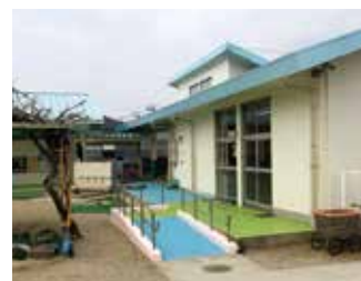
日永中央保育園改修工事
