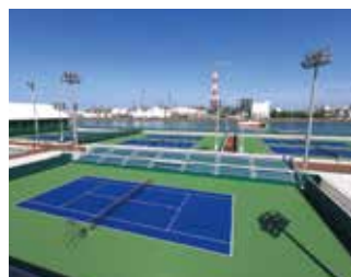
霞ヶ浦緑地運動施設整備
