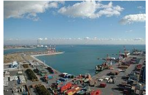
霞ヶ浦地区コンテナターミナルの様子
