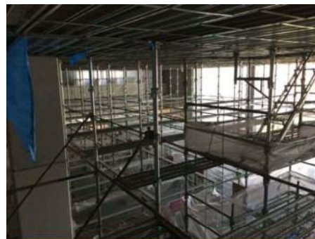
吊天井崩落対策工事の様子
