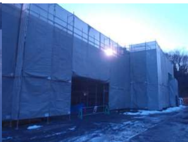
外部 北面施工状況
