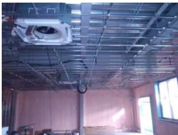
内部 1階会議室施工状況
