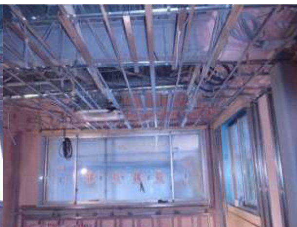
内部 2階食堂施工状況
