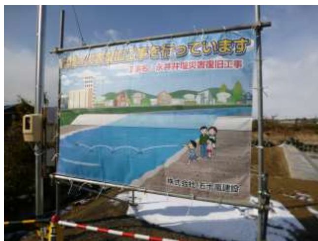
写真4：現場情報案内板掲示状況
