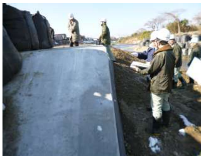
写真2：施工出来型 確認監査
