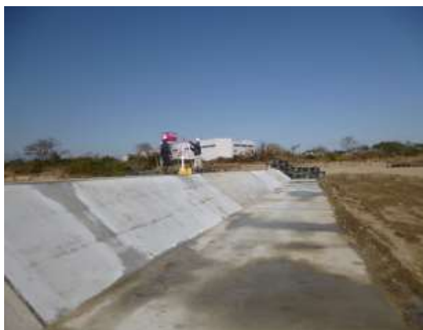
写真3：現場立会検測状況
