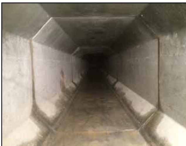
写真4：函渠工施工状況（落差工より上流側を望む）
