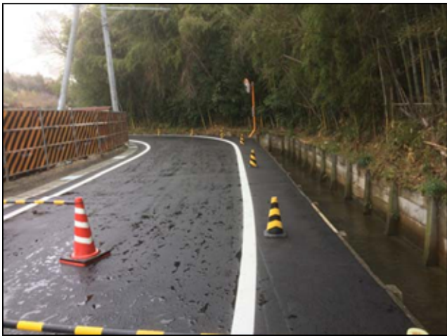
写真1：施工状況（起点側から望む）
