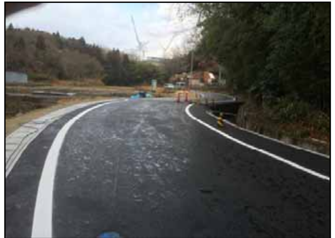
写真2：施工状況（No. 4付近）
