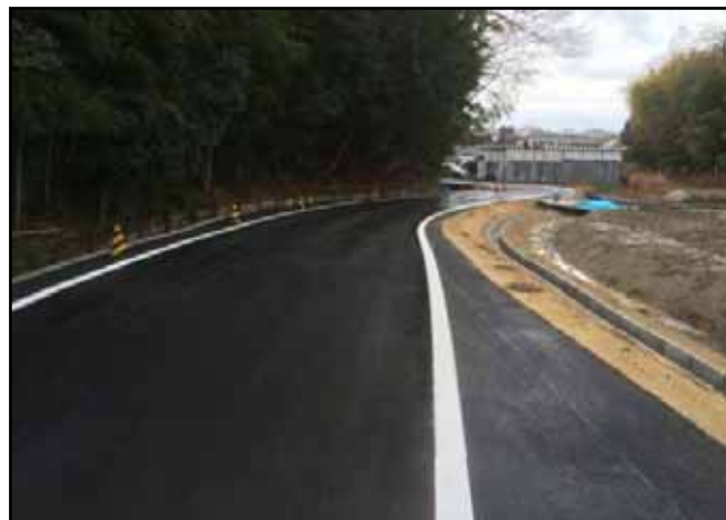
写真3：施工状況（終点側から望む）
