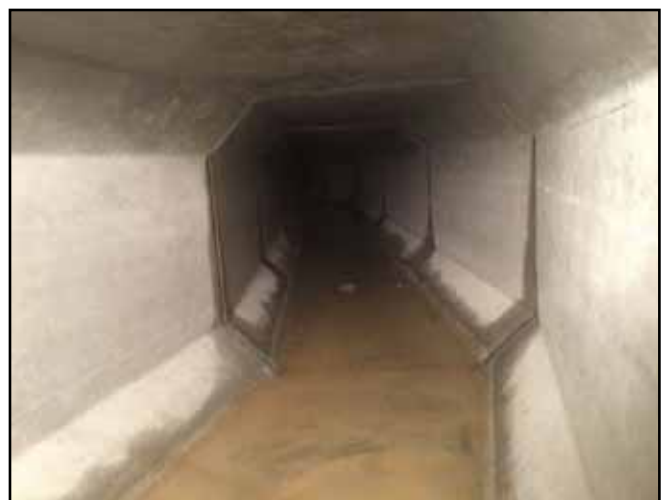
写真5：函渠工施工状況 （落差工より下流側を望む）
