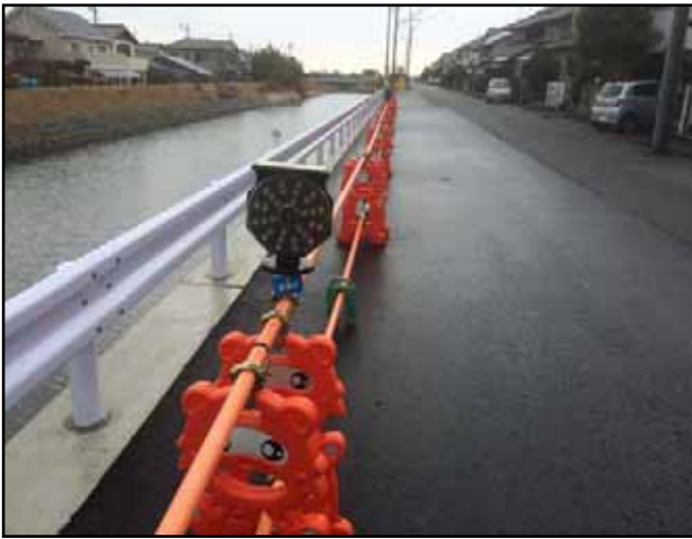
写真1：施工状況（舗装工、ガードレール工）
