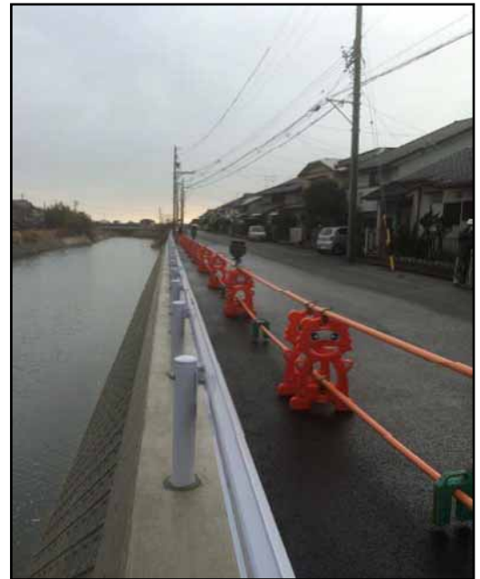
写真2：施工状況（ブロック積工）
