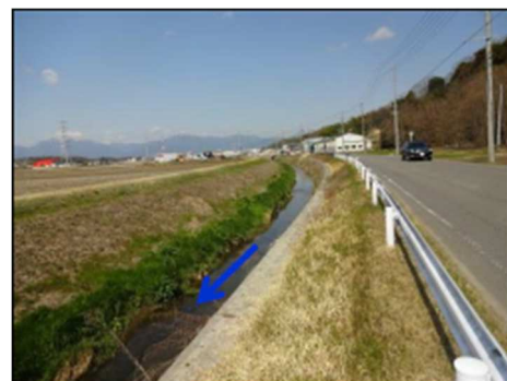
工事完成後 (暫定) (流下能力 2 7 m 3 /s)
