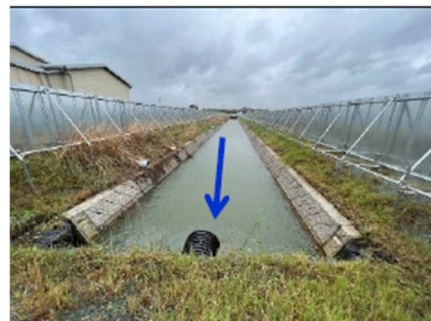
工事完成後 (流下能力 21 m 3 /s)
