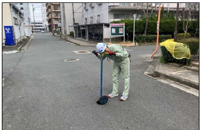
聴音しながらバルブを操作する状況
