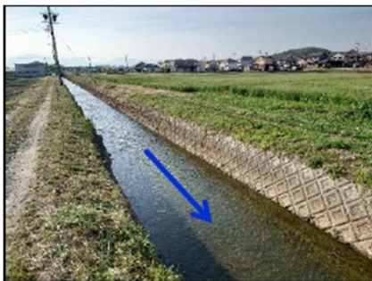
工事着手前 (流下能力 3 m 3 /s)
