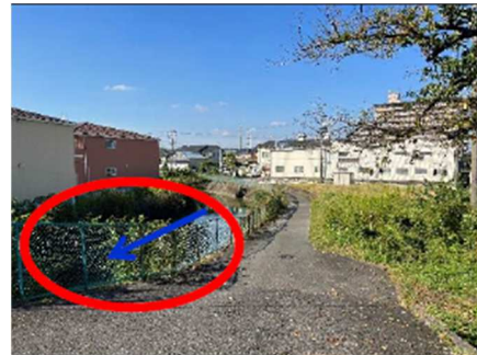
排水機場整備予定地 (下流部)
