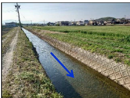
工事着手前 (流下能力 3 m 3 /s)
