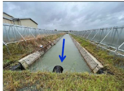
工事完成後 (流下能力 21 m 3 /s)
