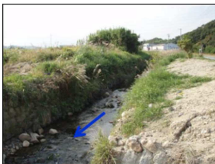
工事着手前 (流下能力 1 2 m 3 /s)
