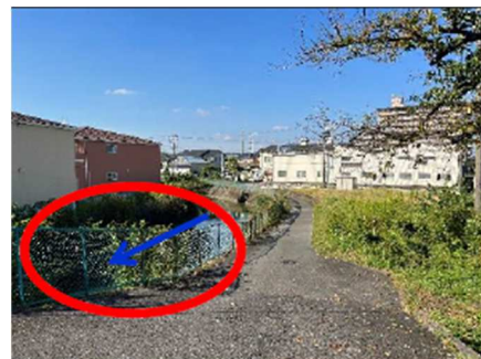
排水機場整備予定地 (下流部)
