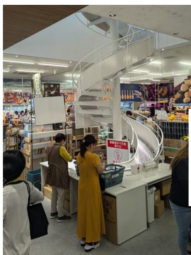
(1階商業施設エリアにある避難はしご。店内から2階へすぐに避難できる)
