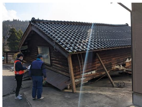
(解体工事着工前の現地確認)
