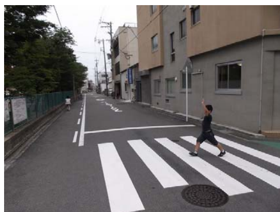
路面表示（施工後）
