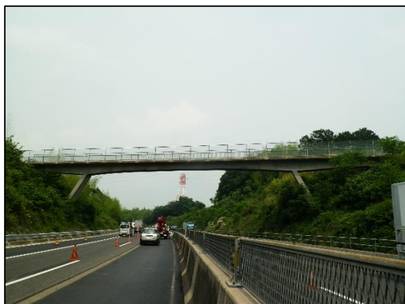
横谷橋 (東名阪自動車道を跨ぐ橋梁)
