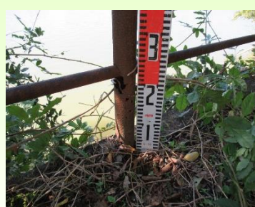
図6 損傷の主な事例
