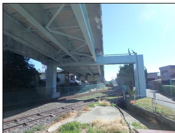
塩浜跨線橋 (近鉄線・JR貨物線を跨ぐ橋梁)
