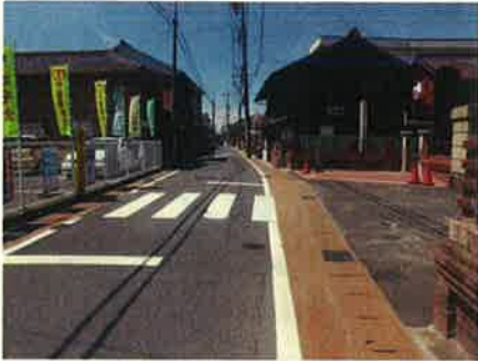
路肩をカラー舗装化した 東海道
