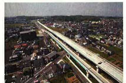
整備が進む北勢バイパス
