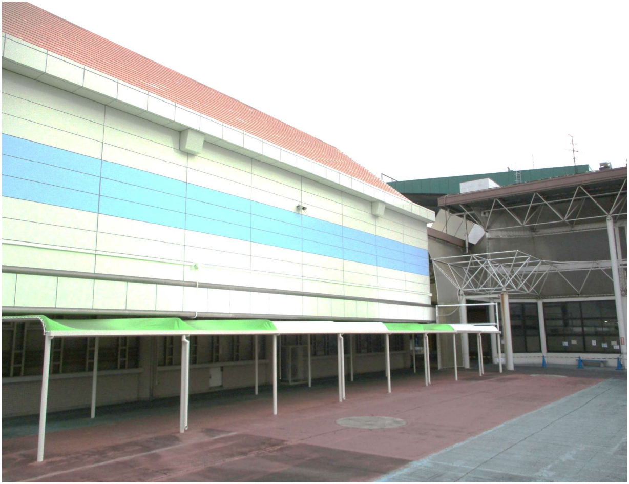
事務所棟 外観
