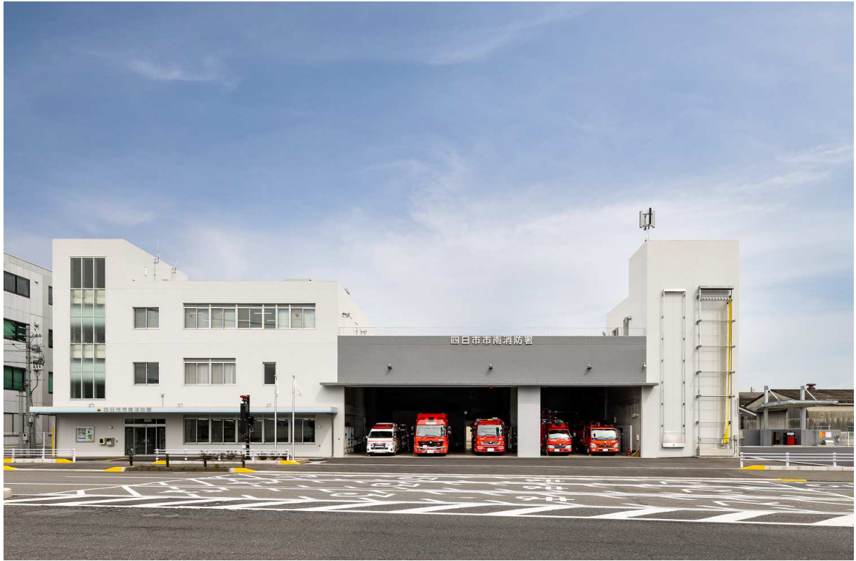
外観(南面) ※外部窓の一部にペアガラス設置
