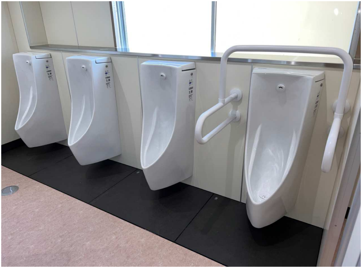
トイレ ※ドライ化及び段差解消
