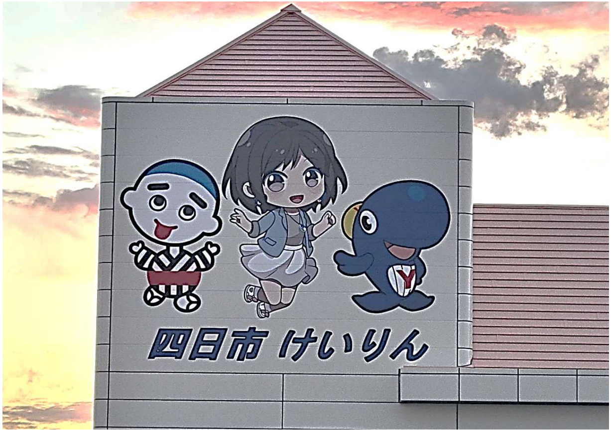
事務所棟 外観
