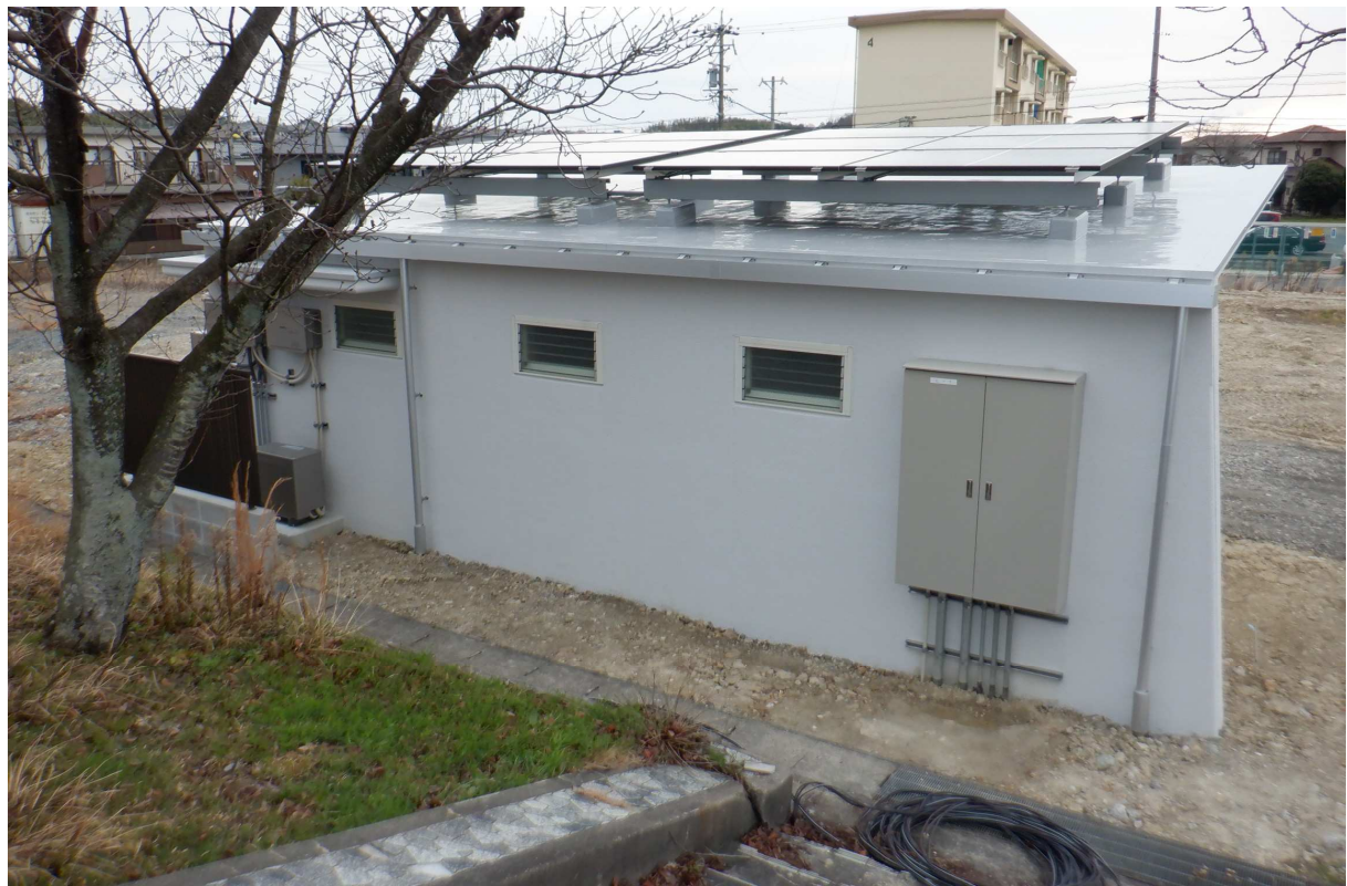
外観(西面) ※太陽光発電設備設置
