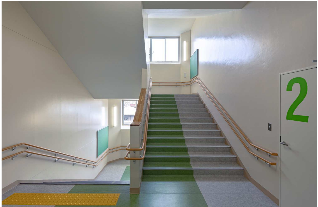
階段 ※階段手摺設置
