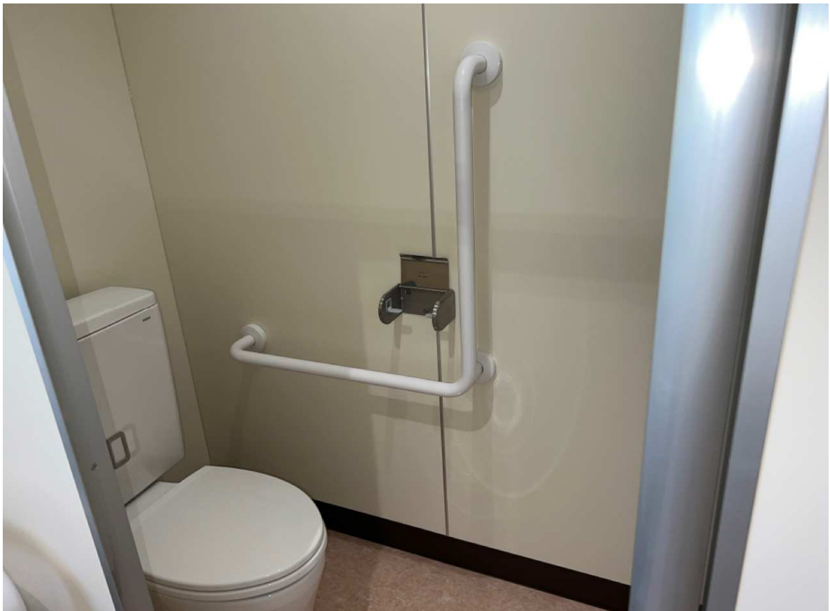
トイレブース内
