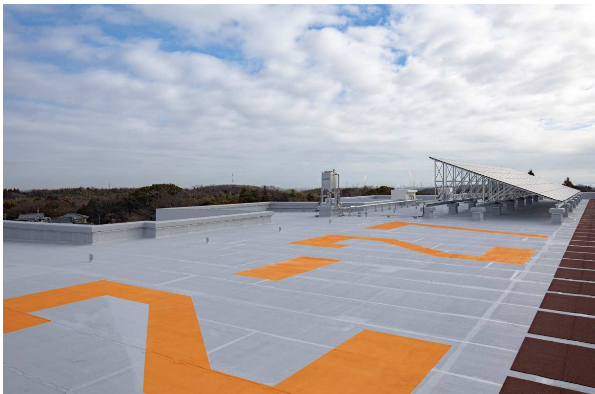
屋上 ※屋上断熱仕様、太陽光パネル設置
