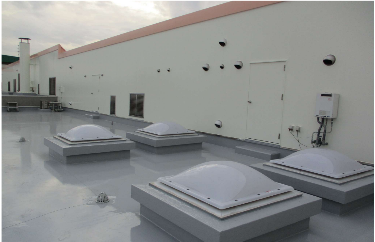
事務所棟屋上
