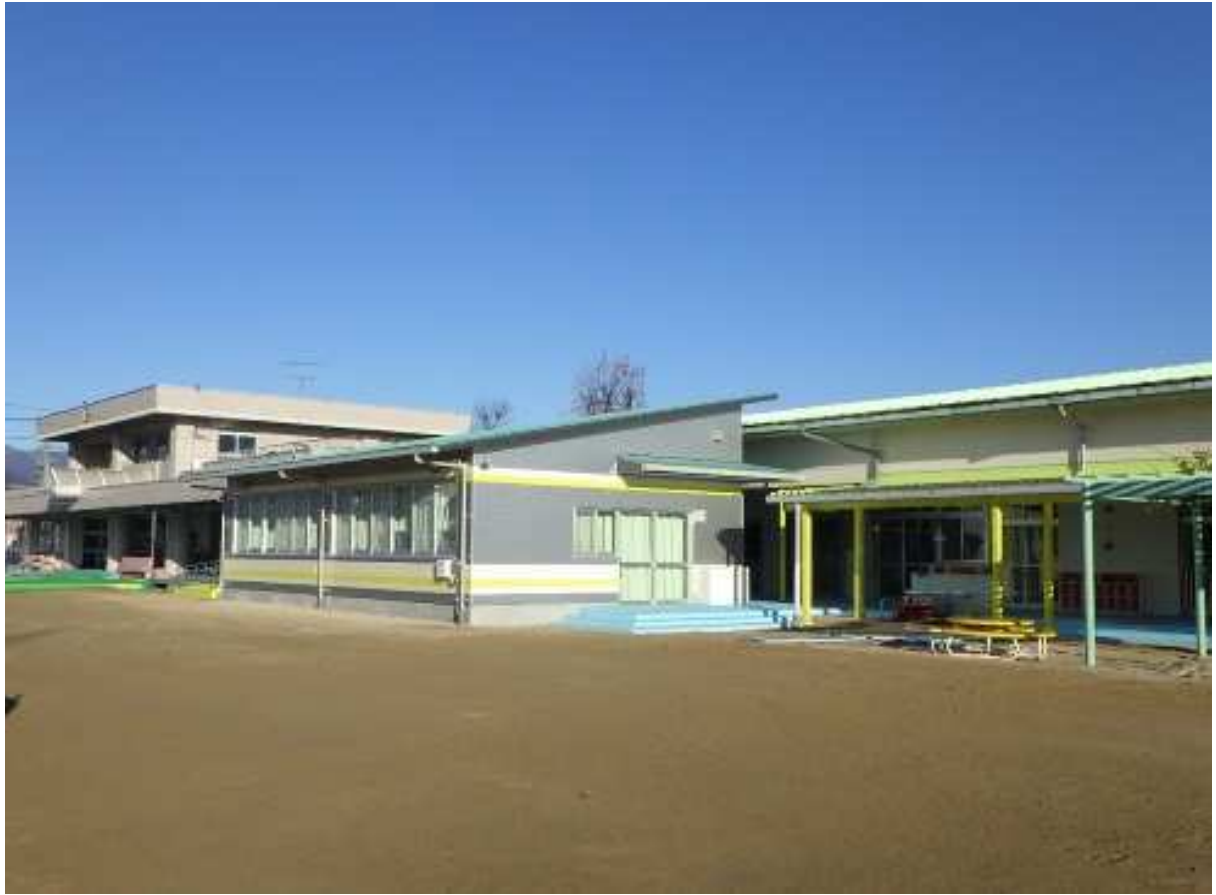
職員室棟外観
