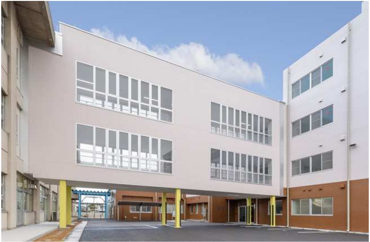
渡り廊下 外観
