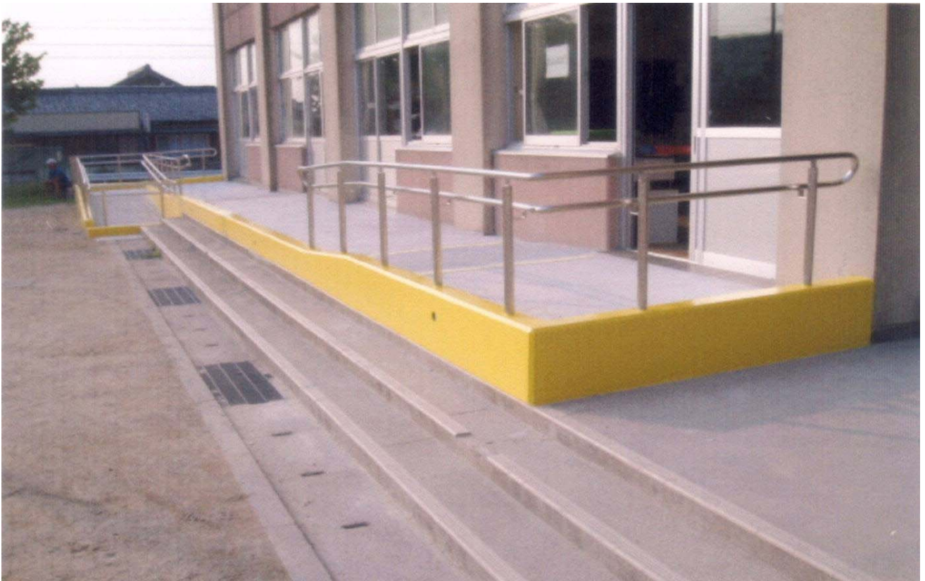
屋外スロープ
