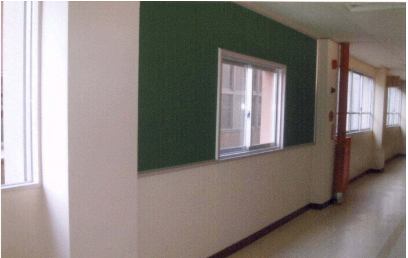
耐震壁(屋内側)
