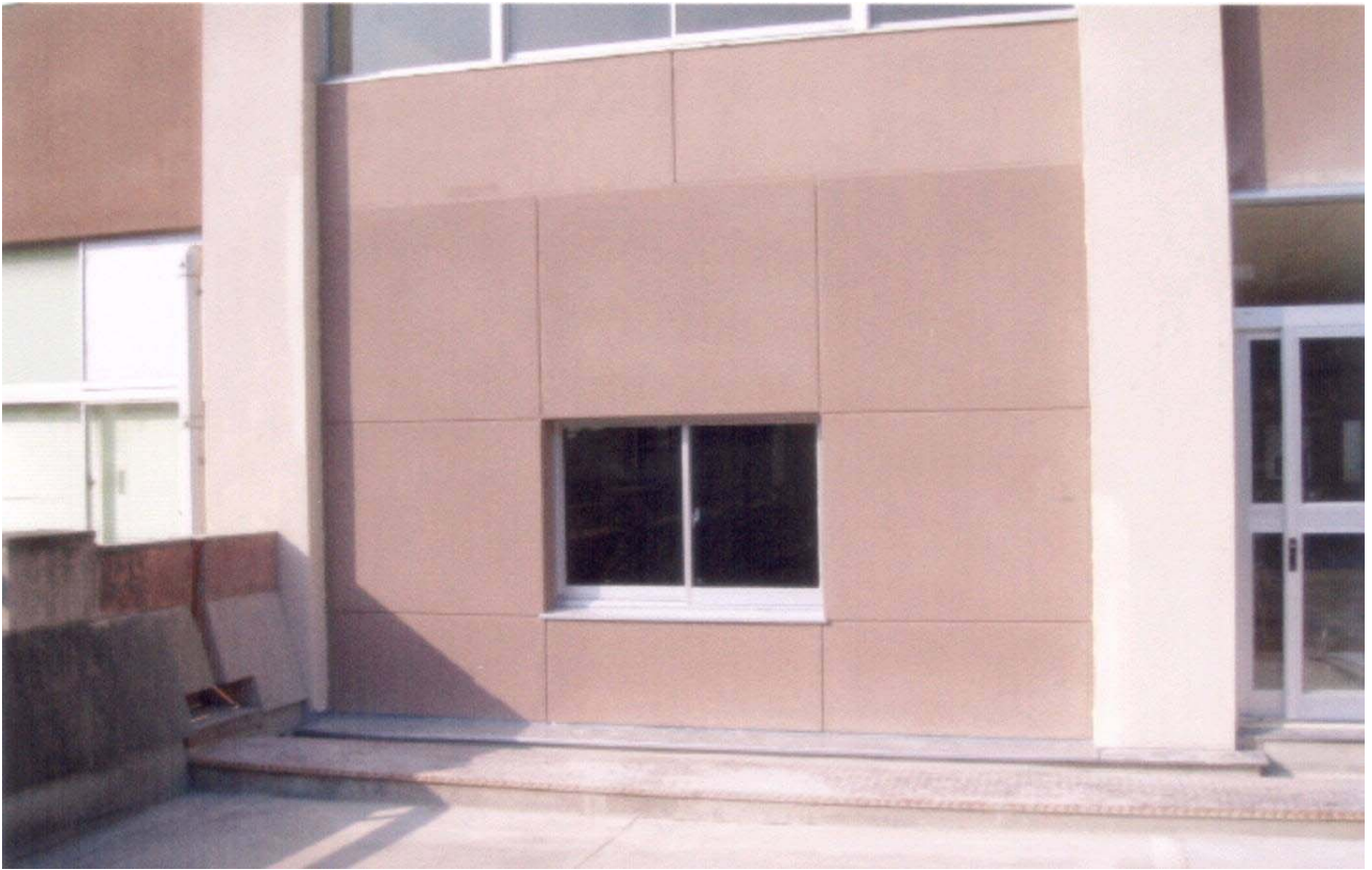
耐震壁(屋外側)
