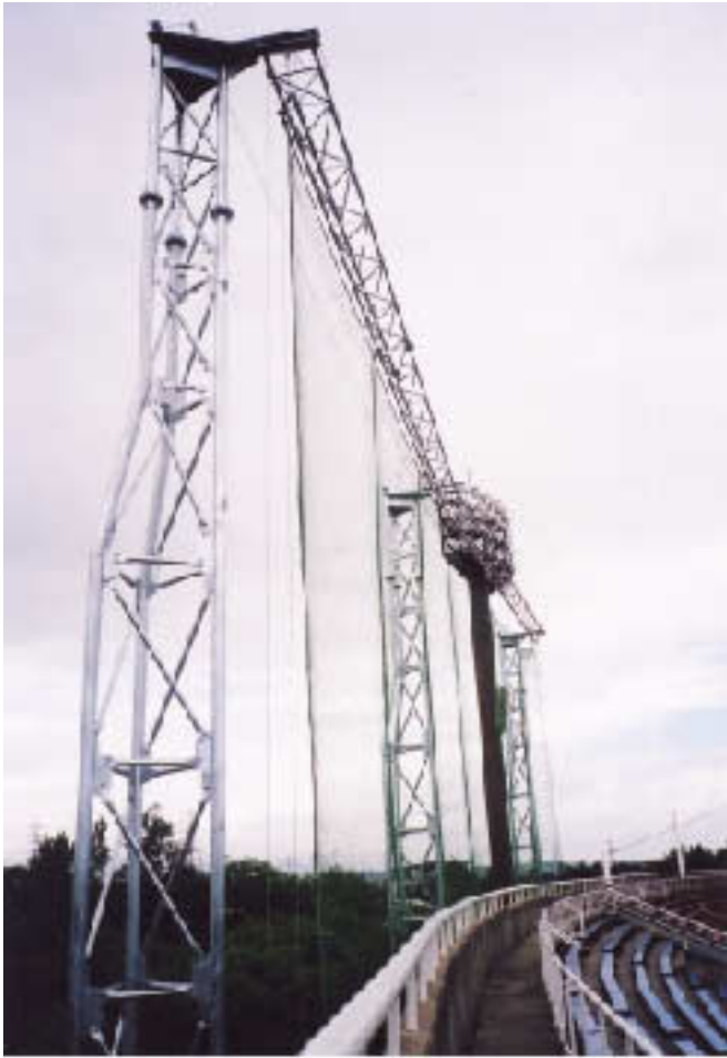
防球ネット（スタンド側より）
