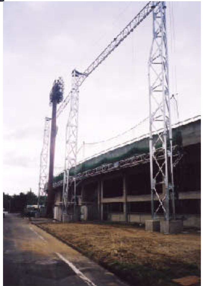
防球ネット（外部側より）
