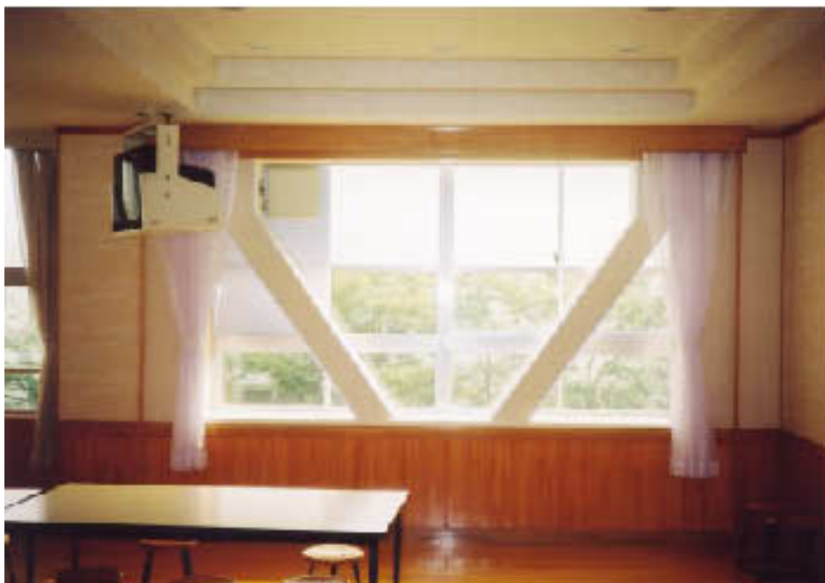
鉄骨ブレース補強 内観)
