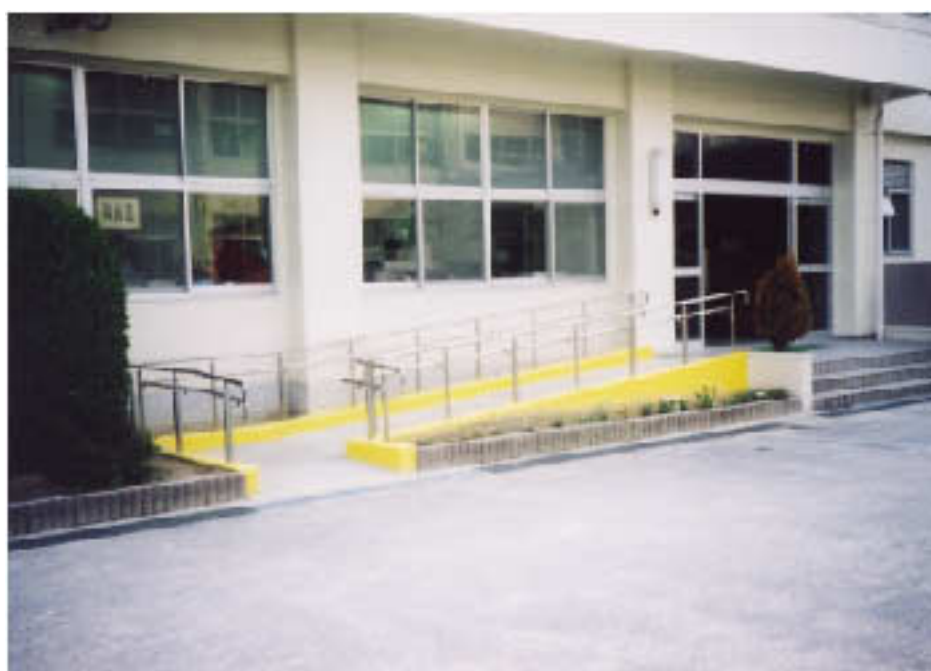
玄関スロープ
