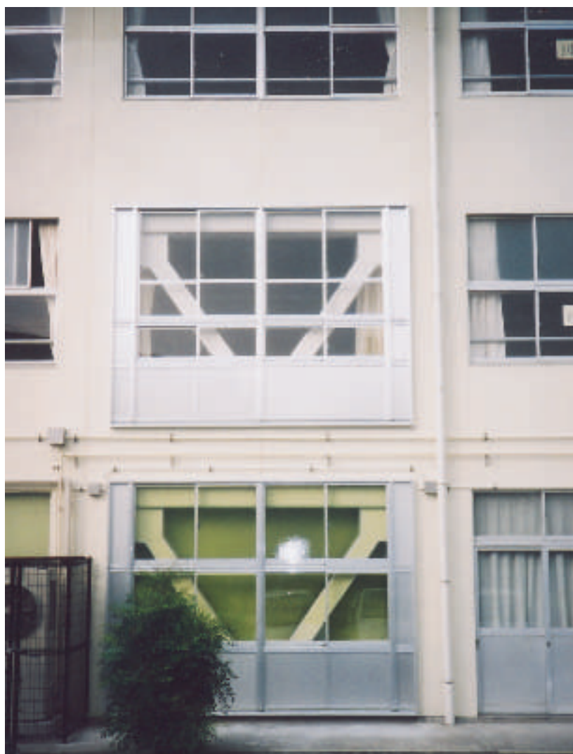
鉄骨ブレース補強（外観）
