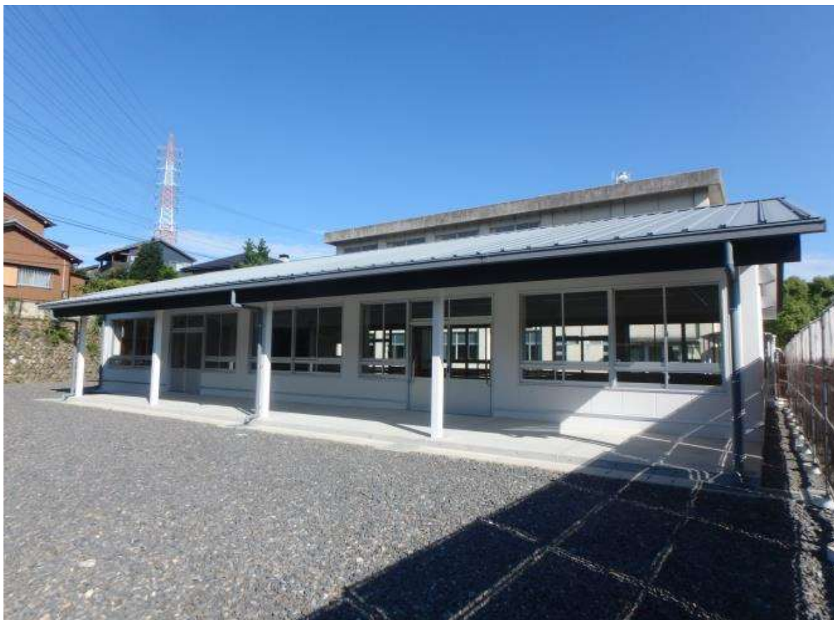
技術教室棟 外観
