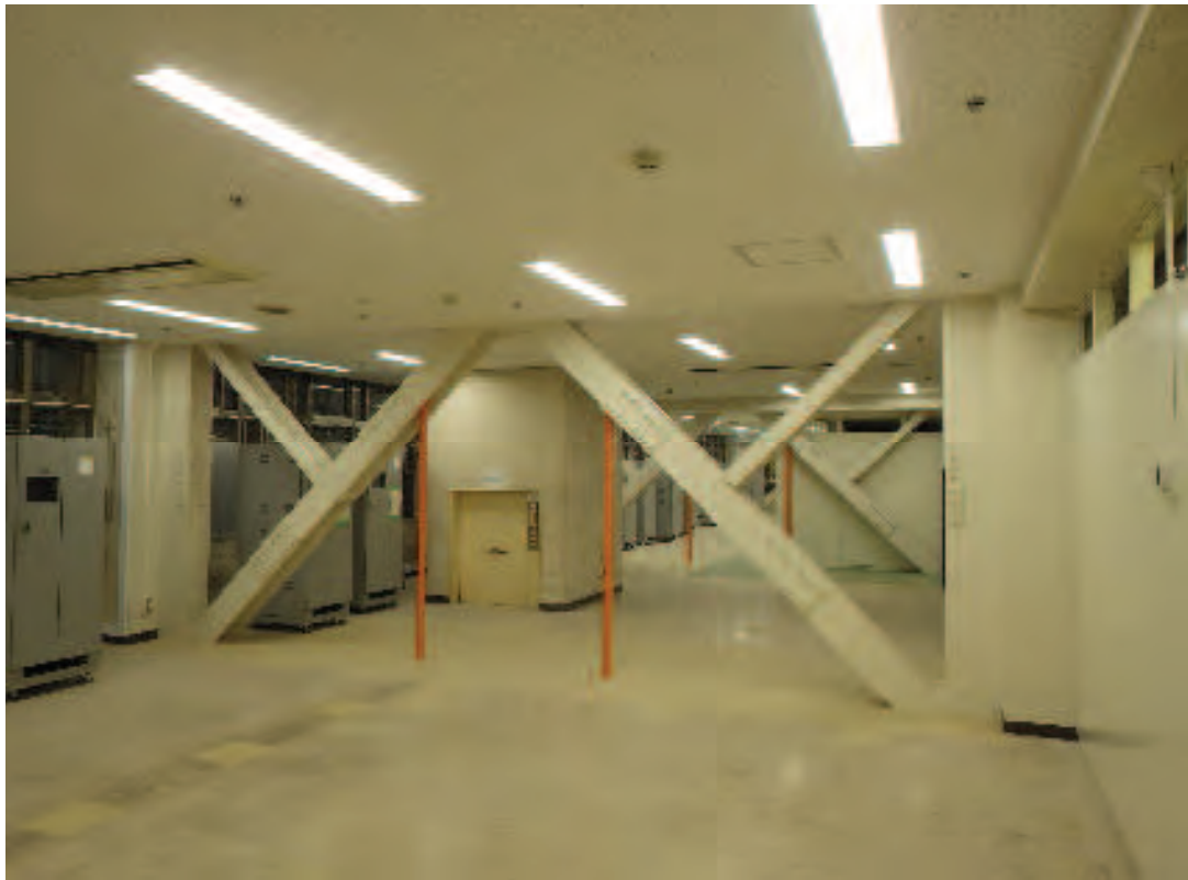
内観(鉄骨ブレース設置)
