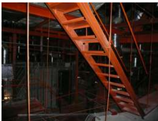
第1ホール天井裏現況
