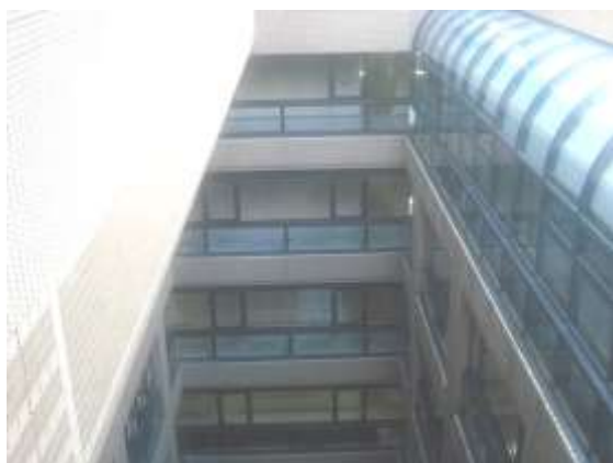
総合会館外壁改修工事
