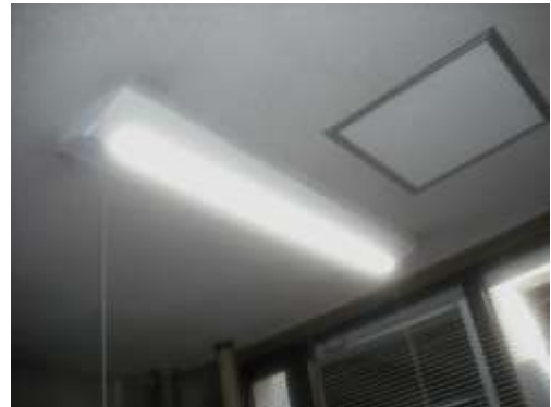
LED照明器具 (消費電力 30W 程度)
