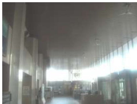
市庁舎天井崩落対策工事实施設計業務委託
