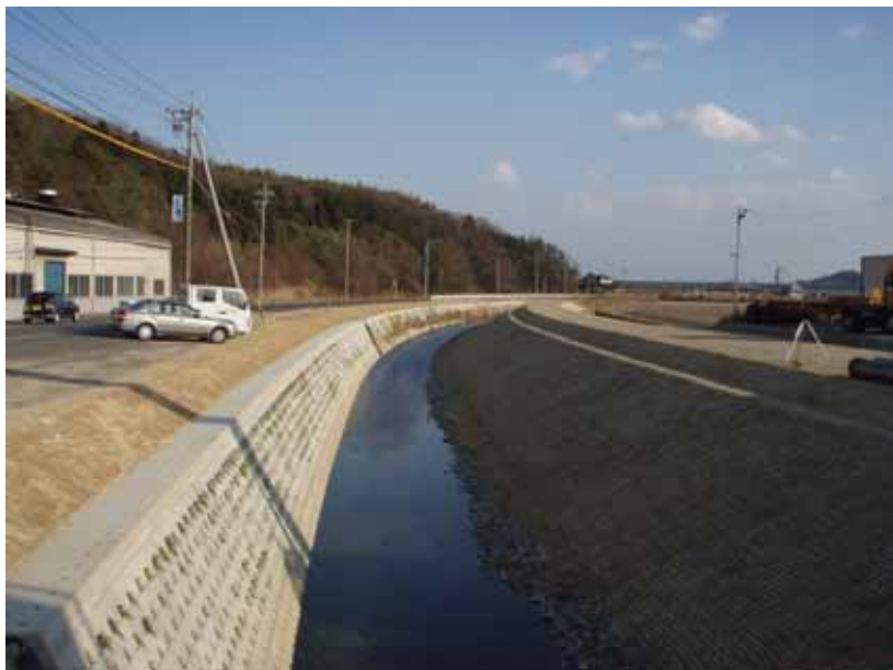
準用河川朝明新川築堤・護岸
