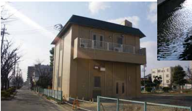
中央通り貯留管ポンプ施設棟
