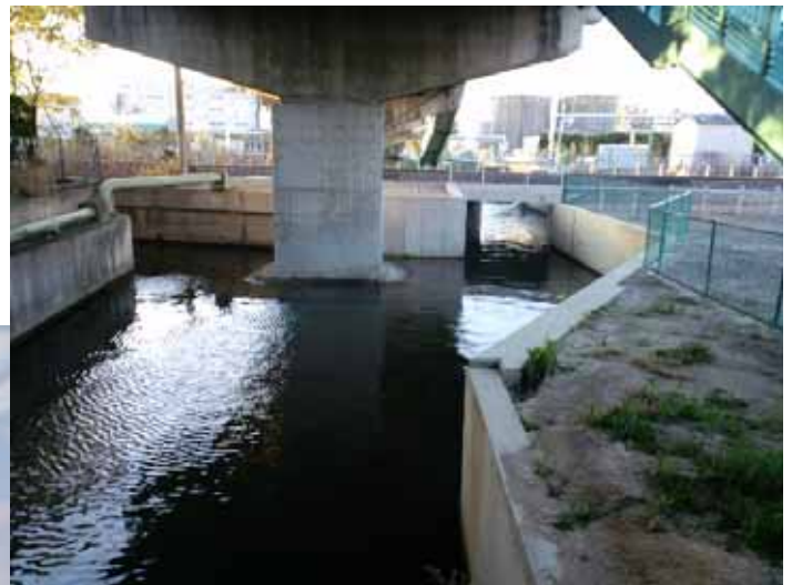
雨池雨水7号幹線水路
