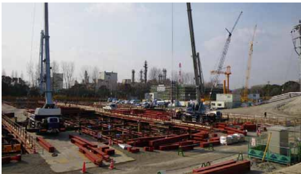
日永浄化センター第4系統建設工事
