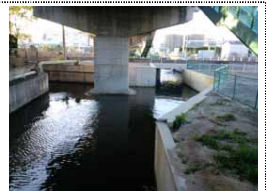
雨池雨水 7 号幹線水路
