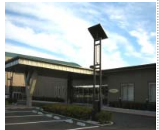
風力・太陽光発電併設駐車場 （楠ふれあいセンター）
