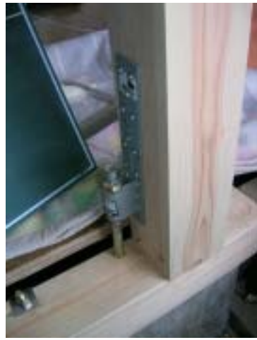
耐震補強工事（柱と土台の固定工事）
