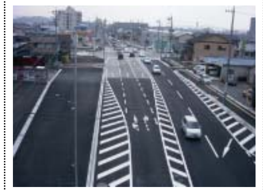
千歳町小生線（整備完了部分）
