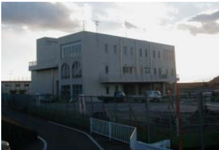
河原田ポンプ場
