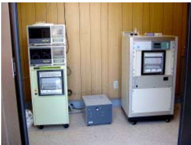
大気汚染状況常時監視機器
