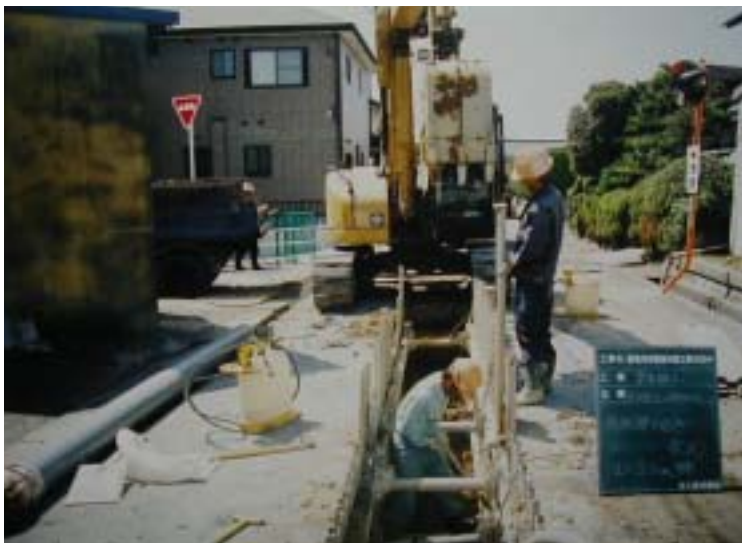
汚水管布設状況
