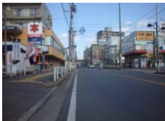
南から望む（施工途中）
