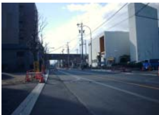
北から望む（施工途中）
