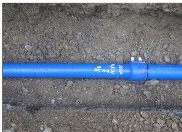
更新後 (配水用ポリエチレン管) ※耐震管
