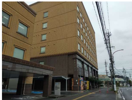
本町プラザ外壁改修及び屋上防水改修工事
