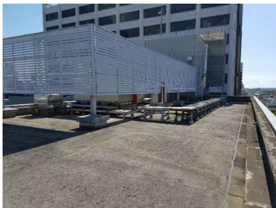
市庁舎北館屋上防水等改修工事
