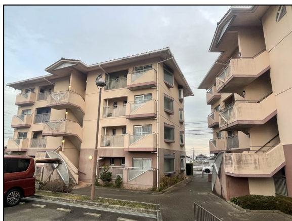
内部泉町市営住宅
