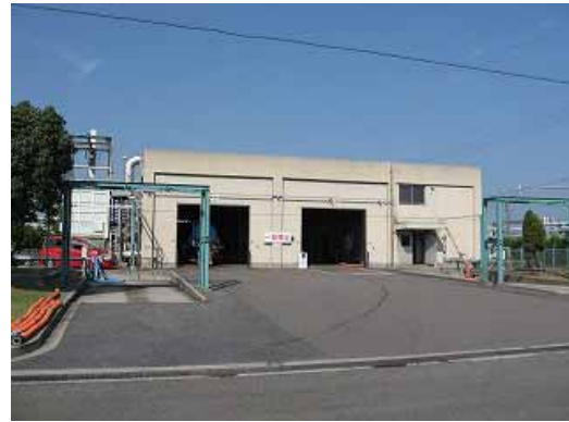
大井の川中継貯留槽
