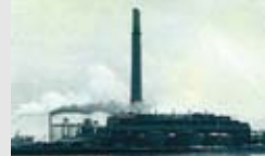
当時世界一を誇った石原産業株式会社四日市工場の大煙突は1/3が倒壊した。(写真提供:石原産業株式会社四日市工場)
