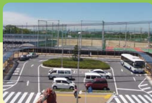
近鉄・三岐富田駅の駅前広場
